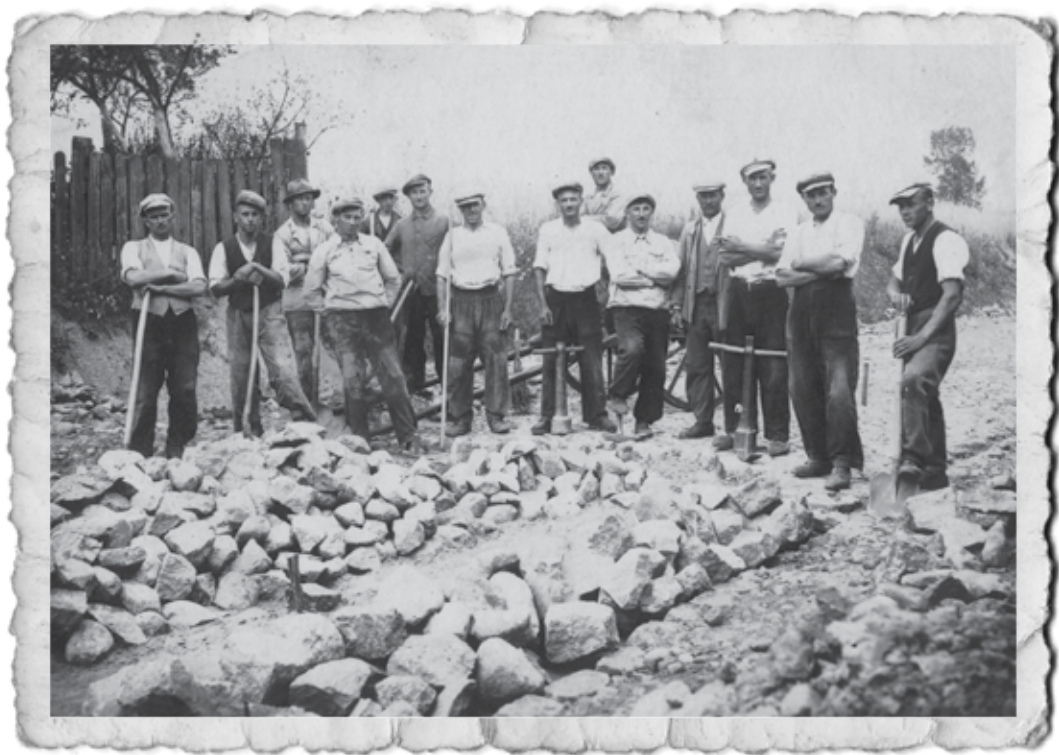
Budowa drogi Piaski-Smogorzewo, budowę rozpoczęto 22 marca 1923 roku.
