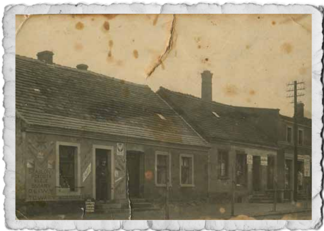
Zdjęcie z 1929 roku. Ulica Gostyńska, dom państwa Talarskich wybudowany w 1832 roku przez Gminę Żydowską, w którym mieściła się szkoła, tażnia rytualna i mieszkanie dla kantora. Katarzyna Talarska po śmierci męża Jana do 1939 roku sama prowadziła sklep.
