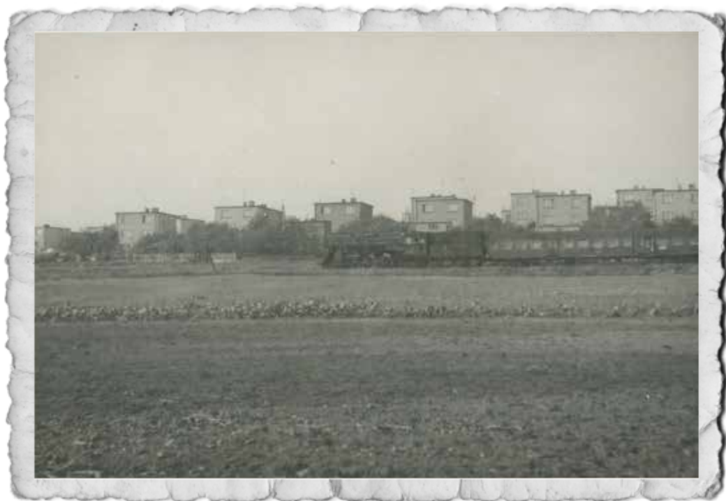
Ulica Kasprzaka w Piaskach przy czynnej linii kolejowej – lata osiemdziesiąte XX wieku.
