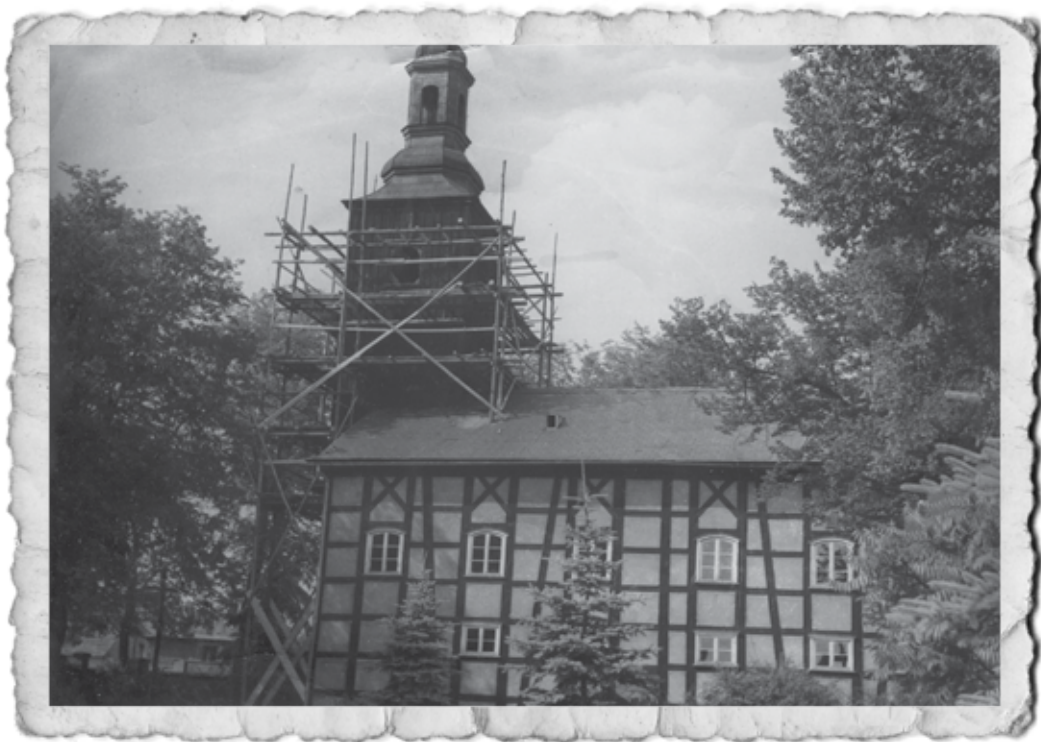
Remont wieży kościoła parafialnego w Piaskach, lata osiemdziesiąte XX wieku.
