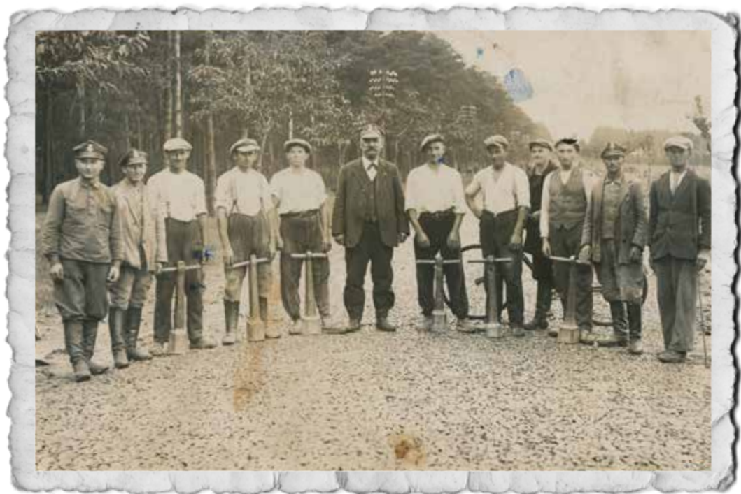
Budowa drogi Piaski-Gostyń. Prace wykonywano od 1 sierpnia 1934 roku do 27 października 1934 roku.
